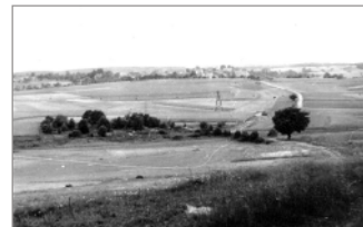
Seilbahn zwischen der Grube Deutschland und der Waschanlage in Seenbrücke.
