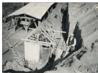
Aufgabestation in der Grube Deutschland
