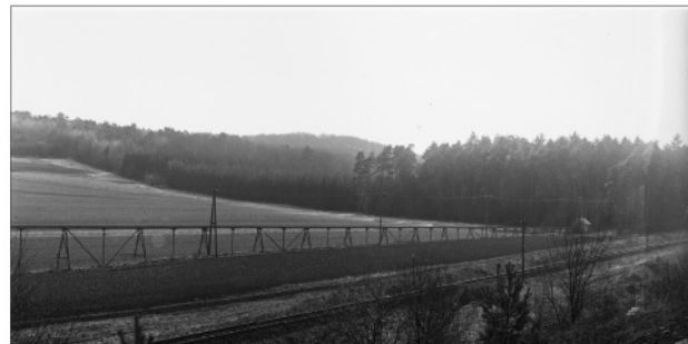
Schlammleitung zwischen den Schlammteichen bei Weickartshain und der Grube Schöne Aussicht bei Freieisen
