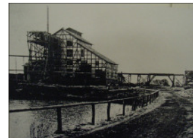
Erzaufbereitung Weickartshain Südsicht mit Wasservorhaltungsbecken
