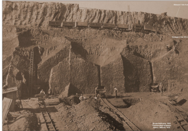
Grube Hoffnung Trichterrutschenabbau
