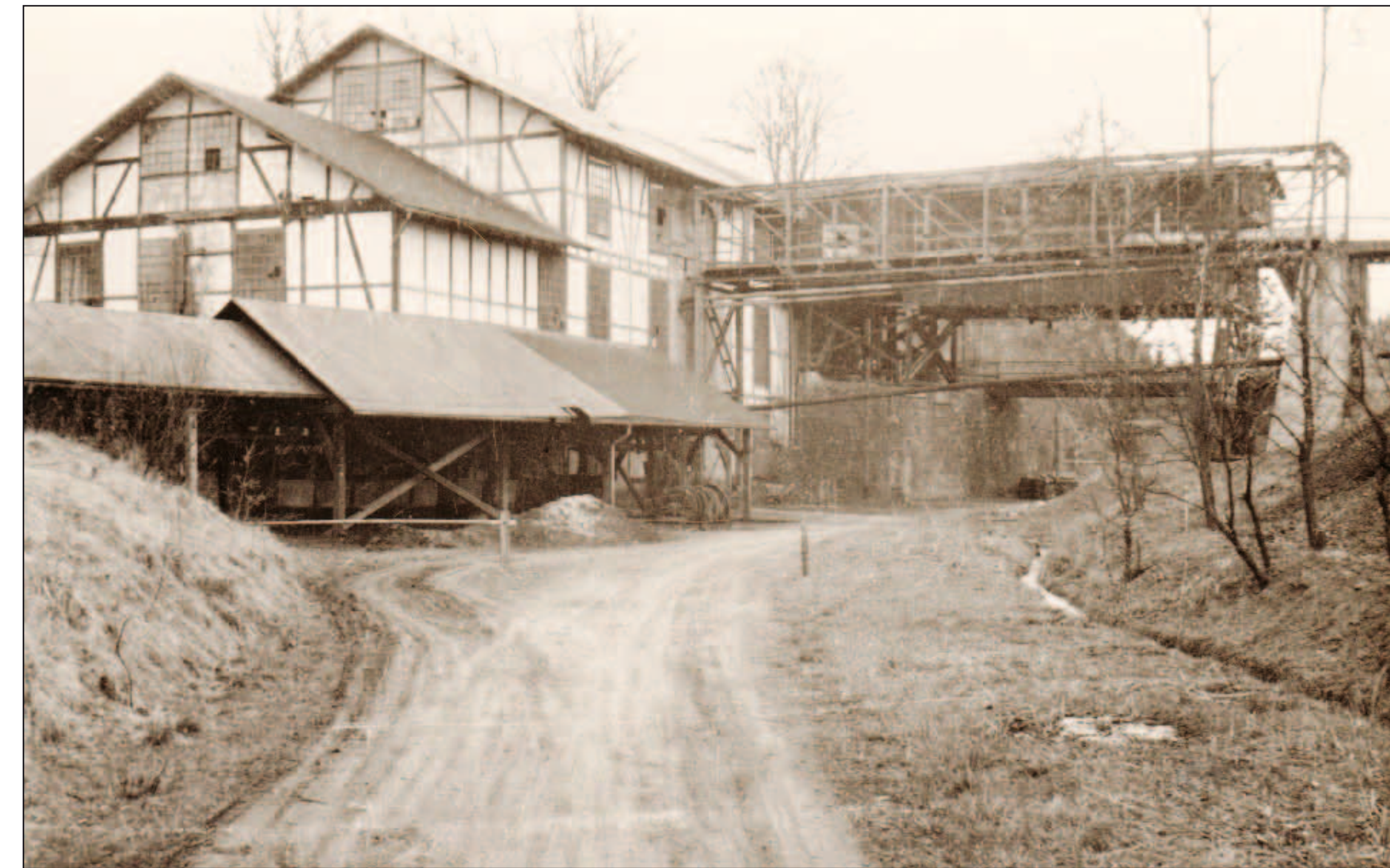
Erzraufbereitungsanlage Ernestine/Albert bei Nieder-Ohmen (Sammlung Roland Becker)
