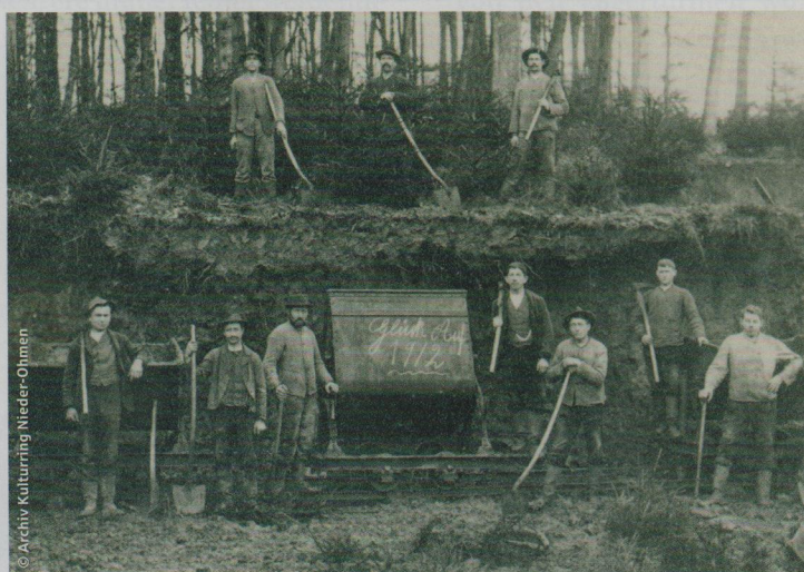
Bevor der erzhaltige Boden erreicht wurde, mussten die Bergleute das unhaltige „Deckgebirge“ entfernen. Dazu gehörte auch das Roden von Waldflächen.
