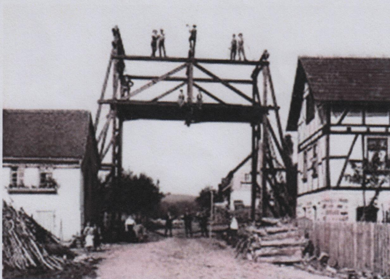
1908 Bau einer Schutzbrücke aus Holz unter der Seilbahn im Neuer Weg in Lumda
