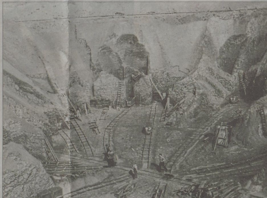
Grube Otto-Elisabeth um 1950, Trichterrutschenbau mit Abfuhr in Loren auf Gleisen.
