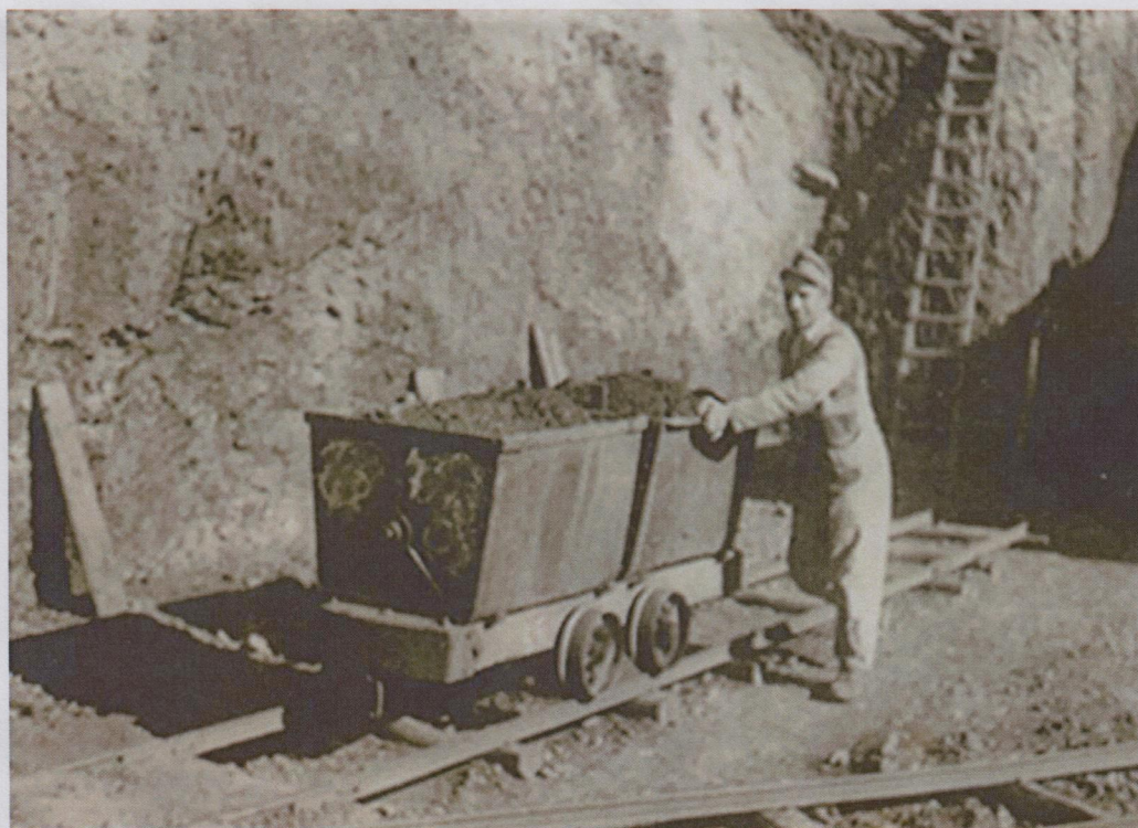
Grube Otto um 1900, Manueller Erztransport mittels Loren (Foto: Archiv Kurt Seim).
