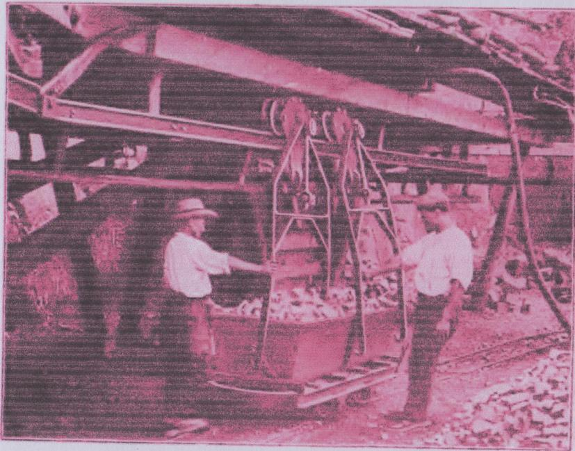
Fig. 62. Einhängen der Wagenkasten in die Gehänge.
